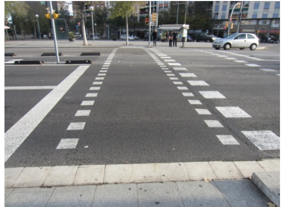
Imatge 14. El carril bici té una amplada de 6 m. i els 4 carrils de vehicles motoritzats, 26 m.
