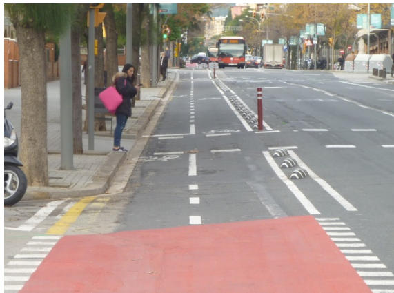
Imatge 51. Carril ben marcat i amb separador físic.
