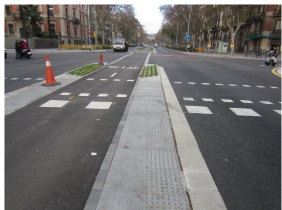
Imatge 29. Mitjana refugi d'1 metre d'amplada amb rajoles adaptades per a invidents.
