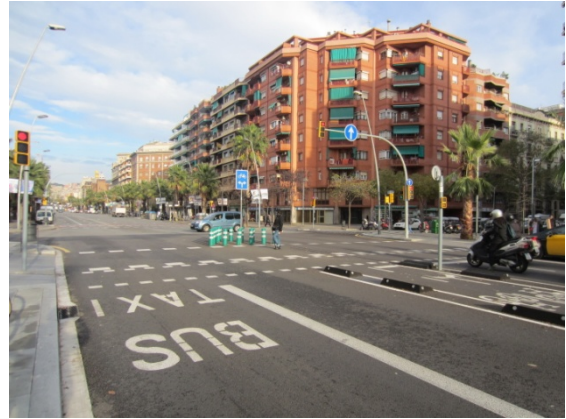
Imatge 18. Finalització del carril bici central a l'alçada amb el carrer Ausiàs Marc. Imatge 19.
