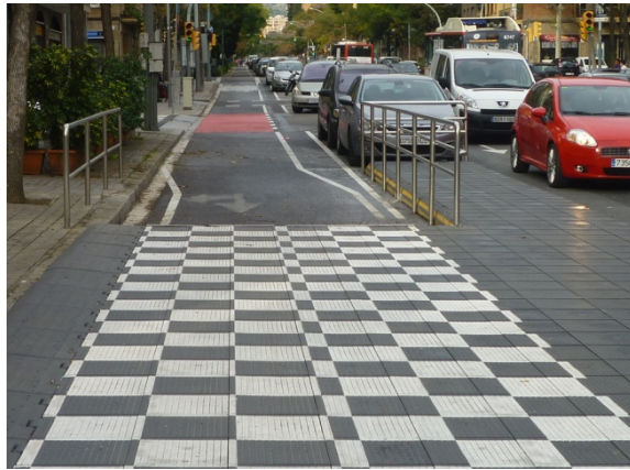
Imatge 53. Plataforma d'accés des de la marquesina a l'autobús.
